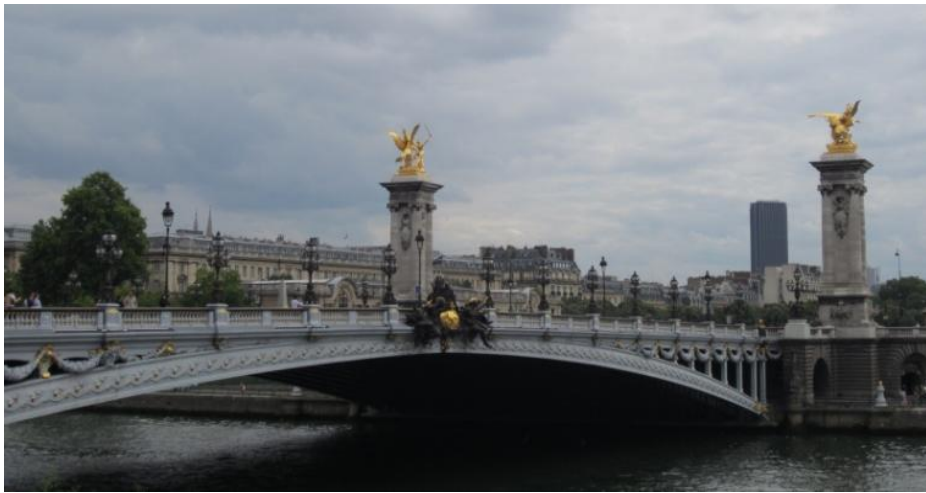
圖1.4 首次採用單跨鋼拱橋結構的亞歷山大三世橋，是19世紀末的建築工程奇蹟
